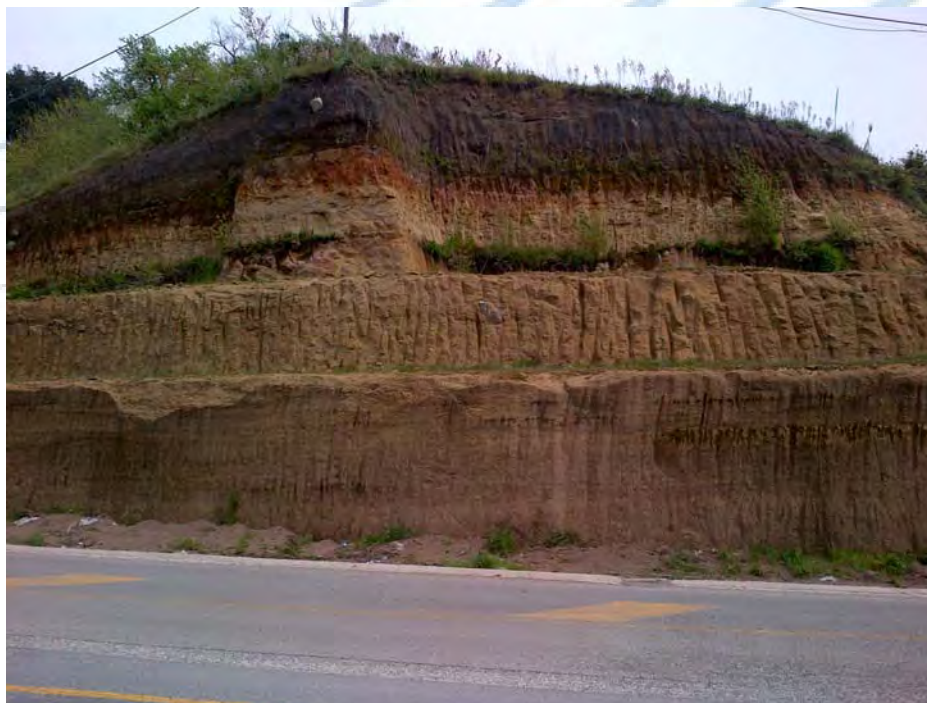
Foto 12 – Caratteristica stratigrafia dei versanti
