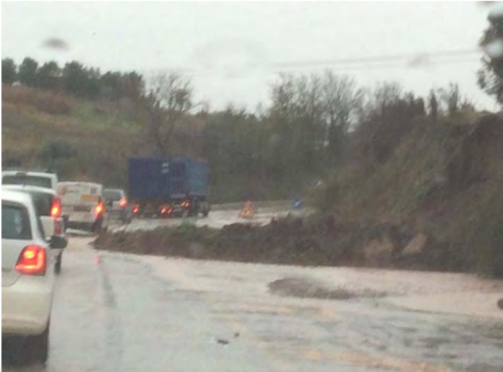
Foto 9 – Frana di un versante su di una intera corsia
